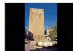
Torre exenta del Castillo de Mengíbar.
